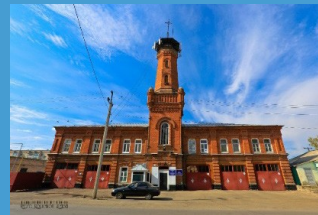
Пожарная часть г. Петровска
